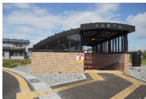
3・2・2内環状線の歩道につながる石江地下道
