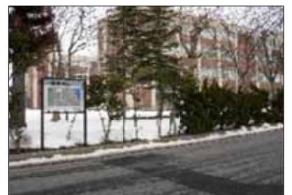
耐震診断が必要な油川中学校。避難所の看板が立てられている。
