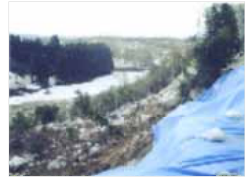
緑ヶ丘団地の斜面崩壊
